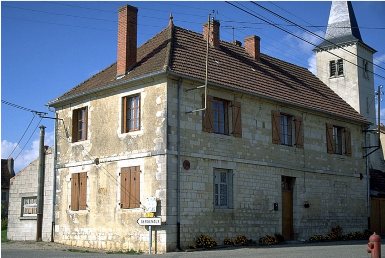
Ancienne école, vue de trois quarts gauche.
