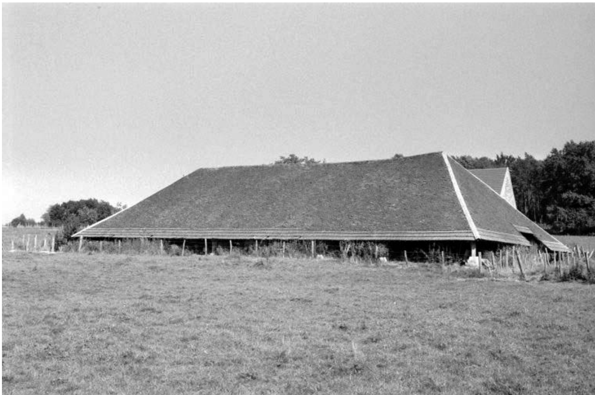
Halle de séchage, depuis l'ouest.
