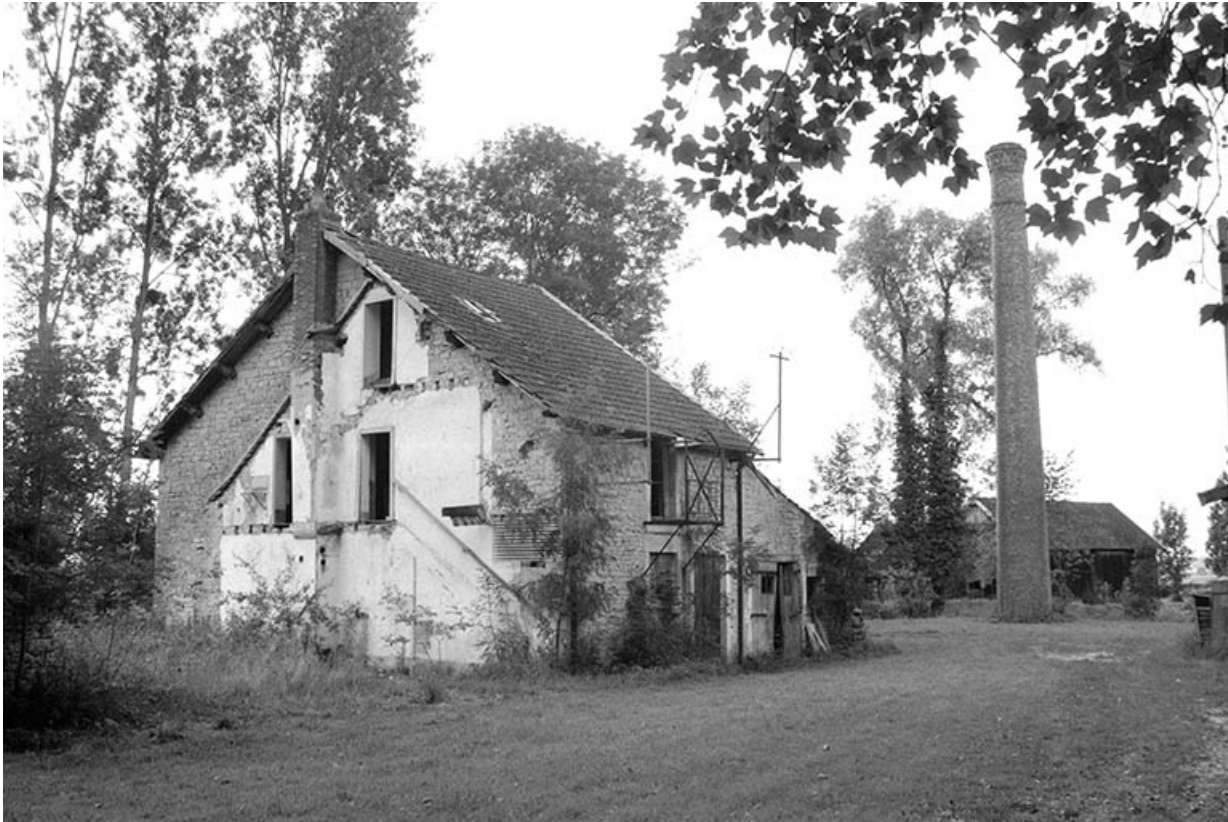
Ecuries (G) et cheminée d'usine (F).
