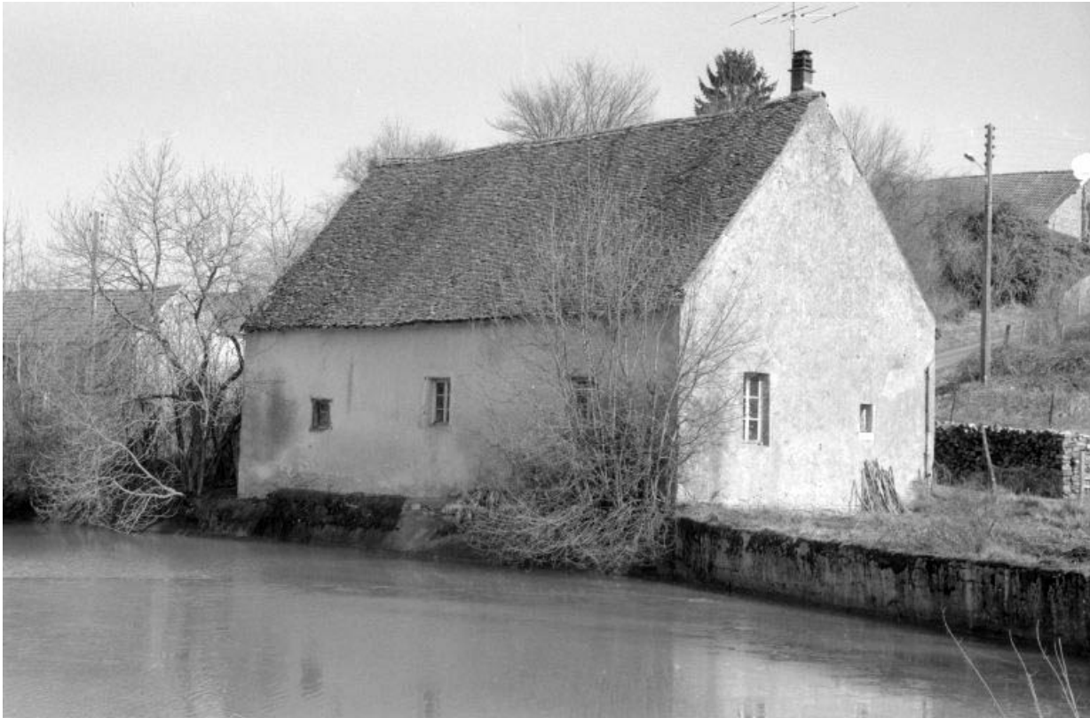
Façades postérieure et latérale gauche du logement.
