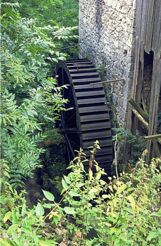
Vue en plongée de la roue hydraulique.
