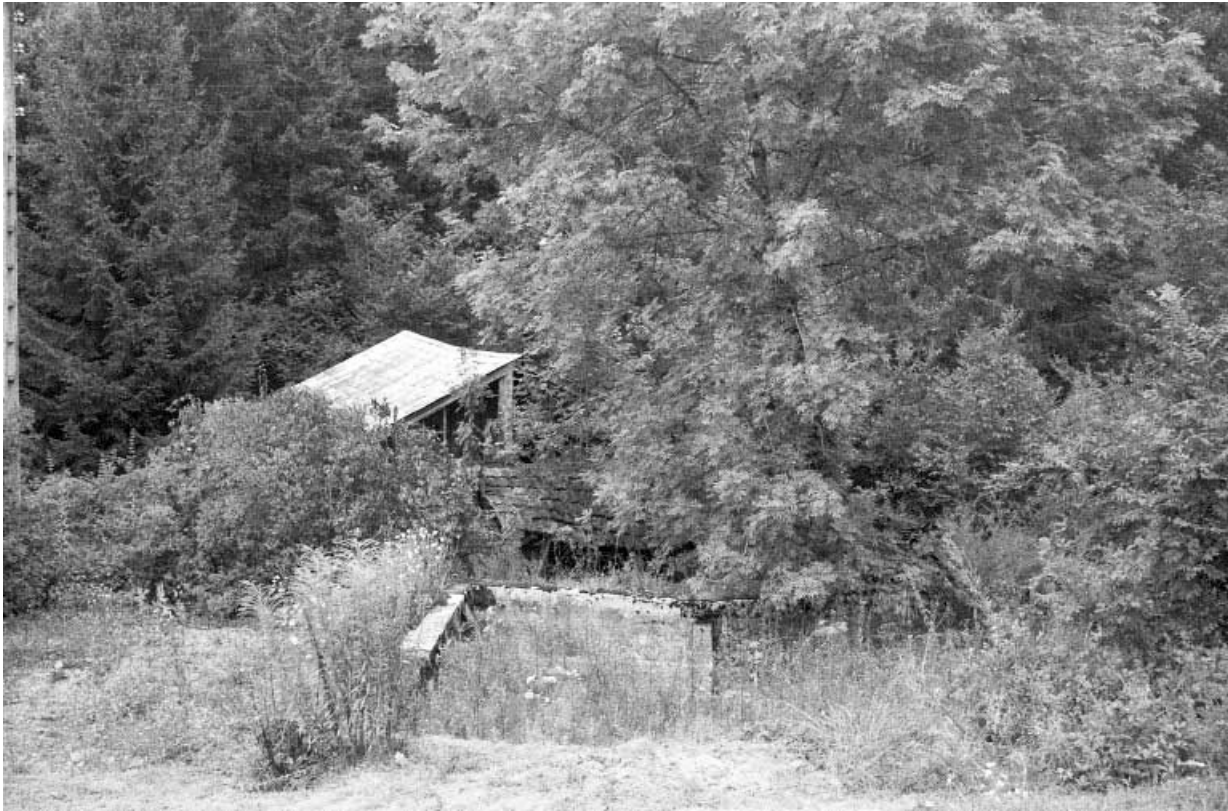
Bassin de retenue et atelier (A).
