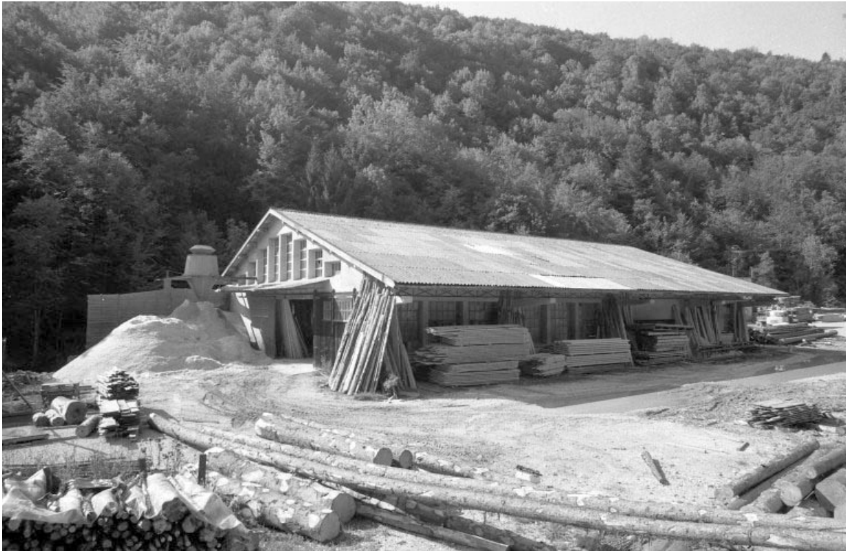
Façade latérale gauche de la scierie.
