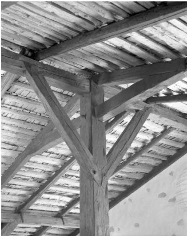
Détail de la charpente : assemblage du poteau avec la faiçade.
