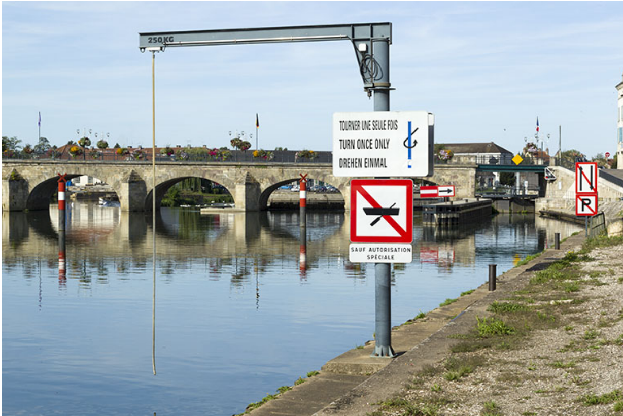
Instrument permettant d'ouvrir l'écluse de manière automatique.
