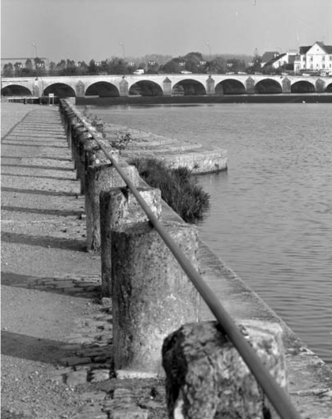
Vue d'ensemble depuis le quai de l'Ecluse.
