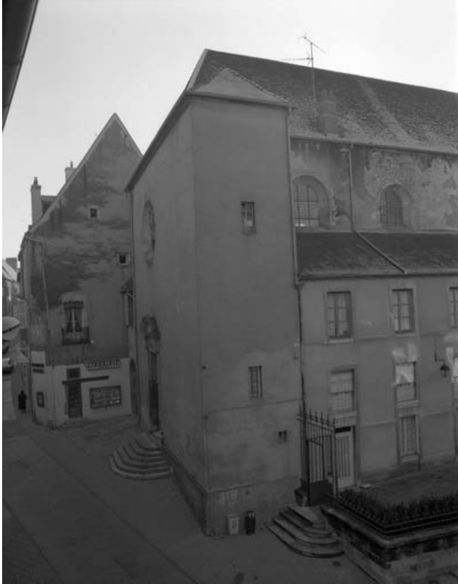
Chapelle : façade antérieure de trois quarts droit.
