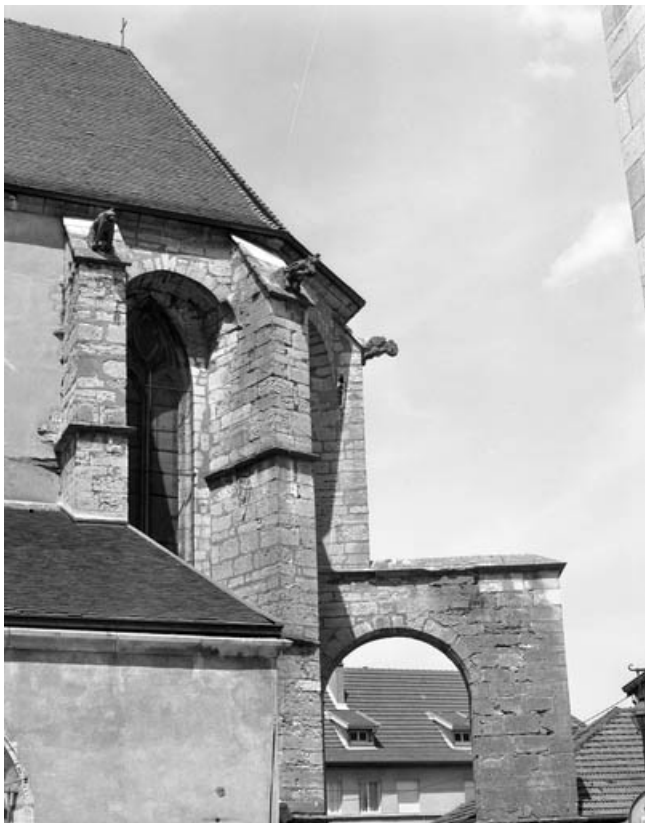
Chevet : détail des contreforts partie droite.
