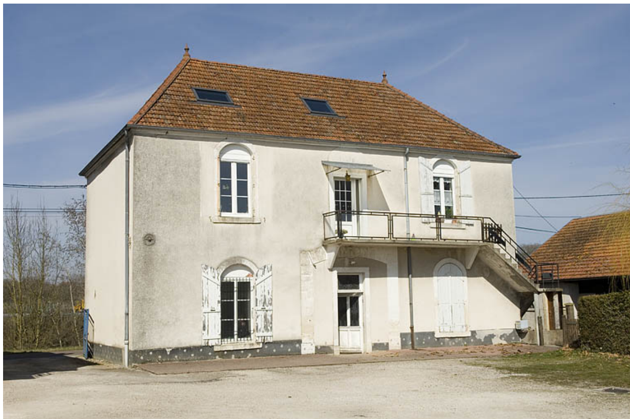
Logement patronal et bureau. Façade sud.
