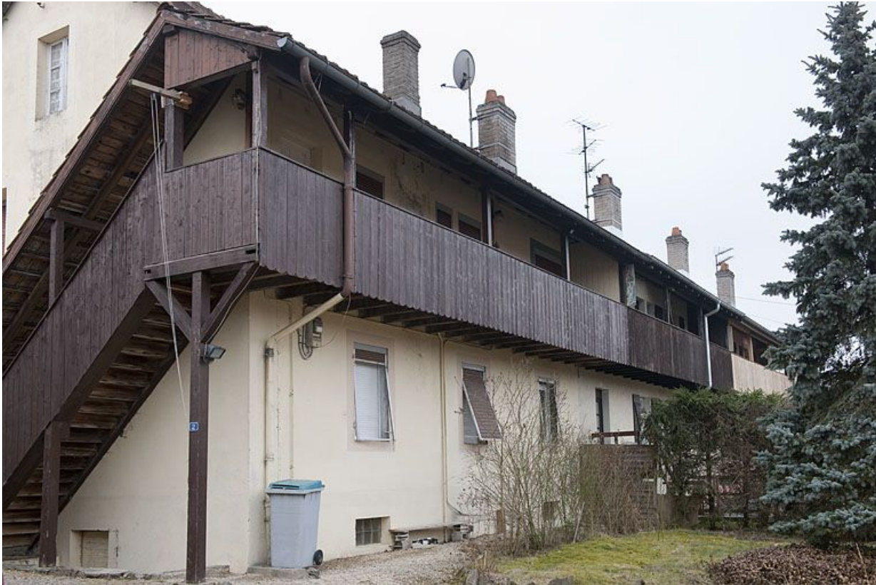
Immeuble (12 logements ?). Façade postérieure.
