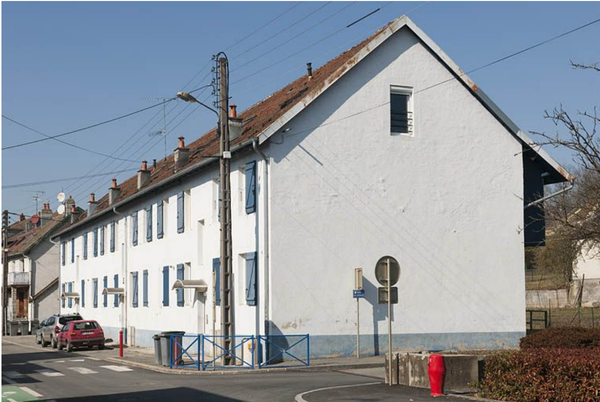
Immeuble de 12 logements vu depuis le sud-est.
