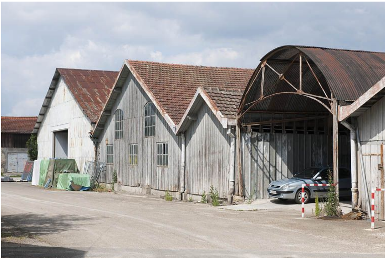
Pignons des magasins et entrepôts industriels.
