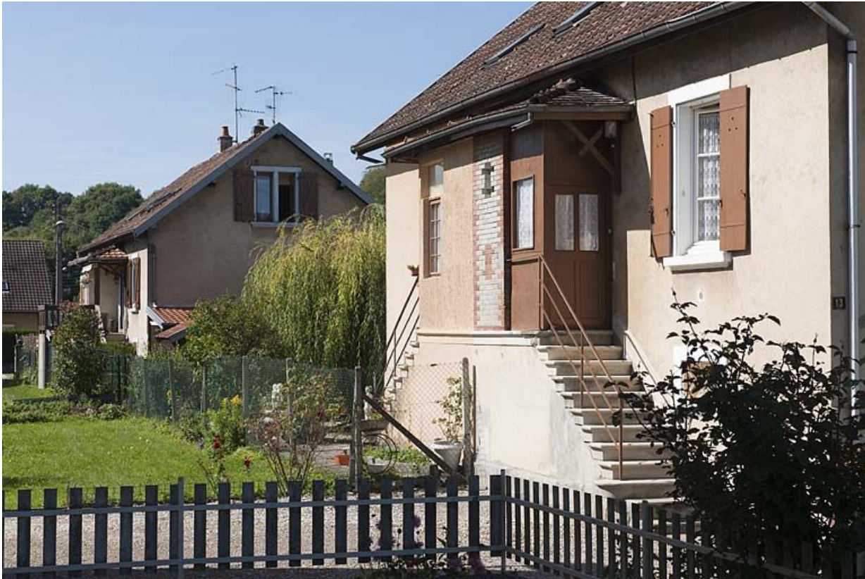
Maisons jumelées. Vue de trois quarts.
