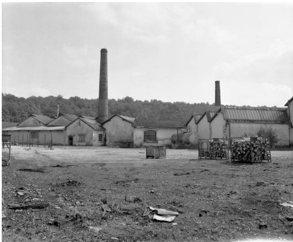
Ateliers de fabrication depuis l'ouest en 1981.
