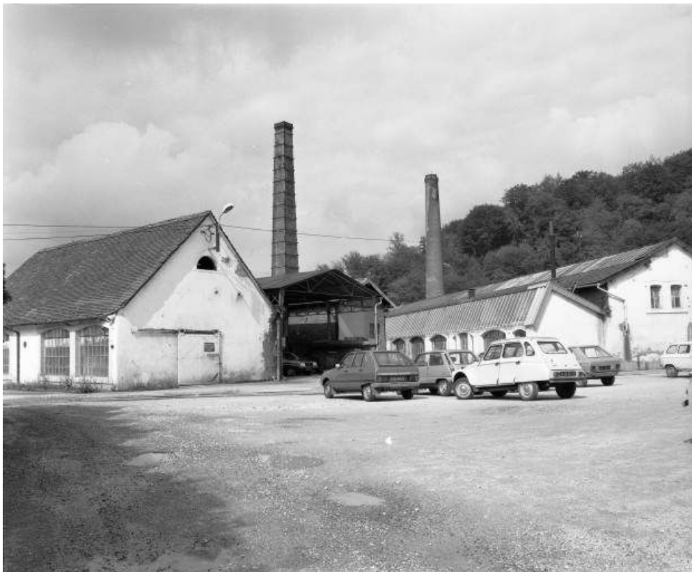
Ateliers de fabrication depuis l'est en 1981.
