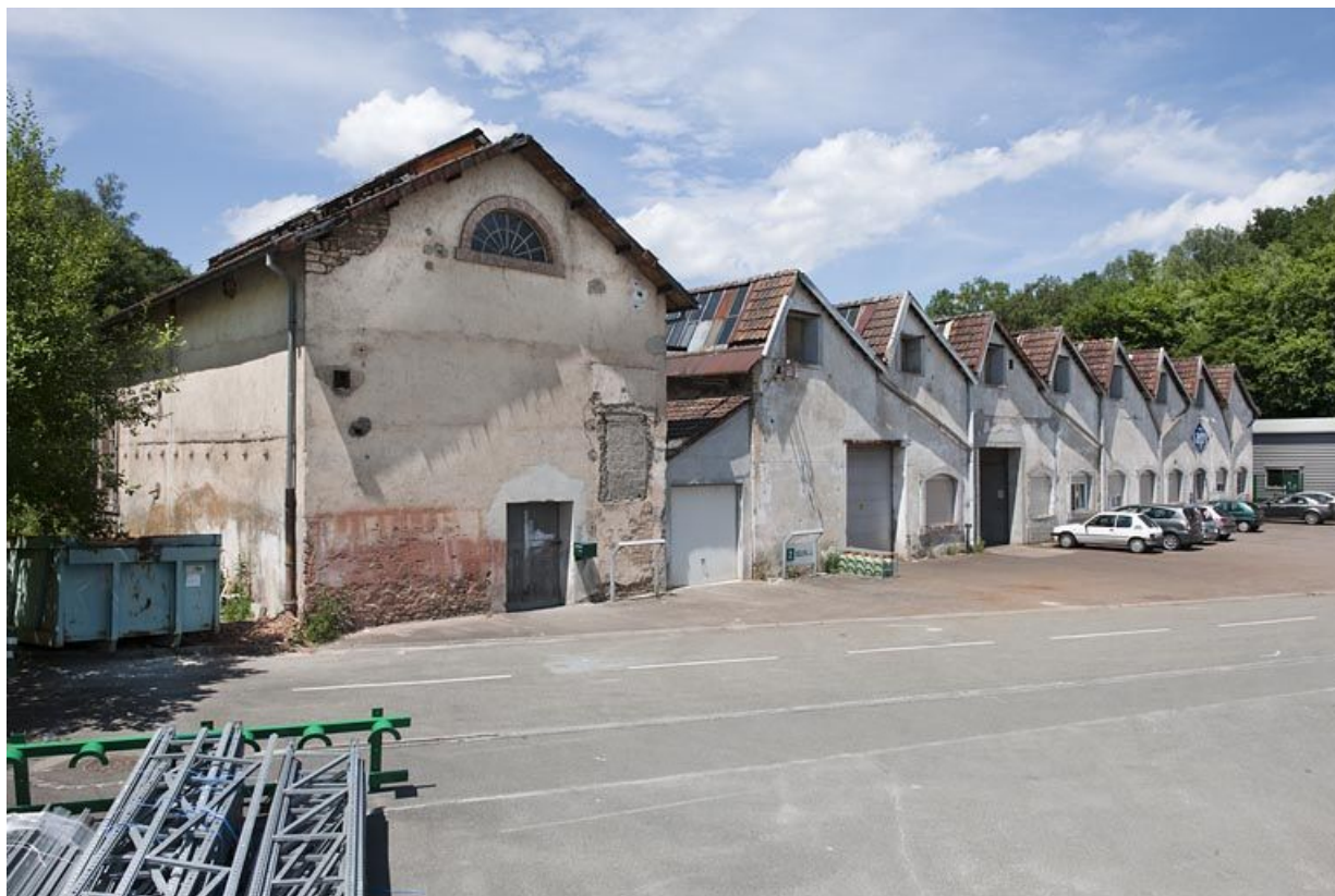
Atelier de fabrication des pompes. Mur-pignons est.
