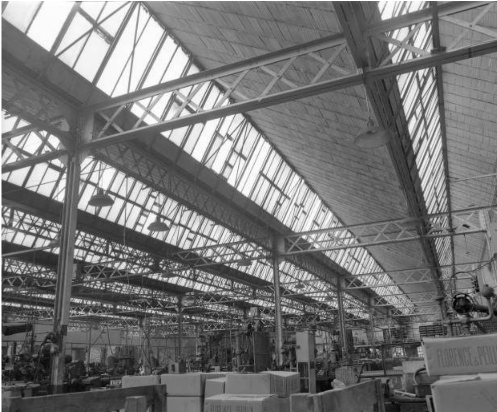
Vue intérieure de l'atelier des pompes en 1981.
