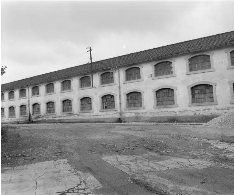
Façade nord de l'atelier des pompes en 1981.
