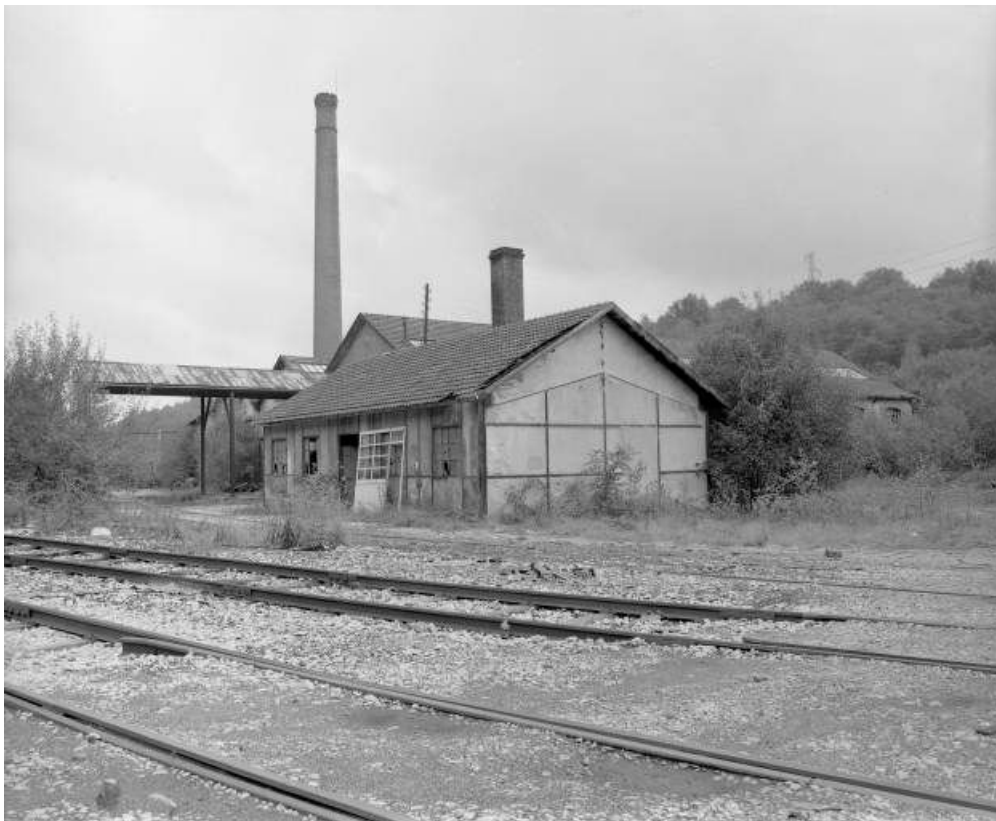
Chaudière devant l'atelier de galvanisation en 1981.
