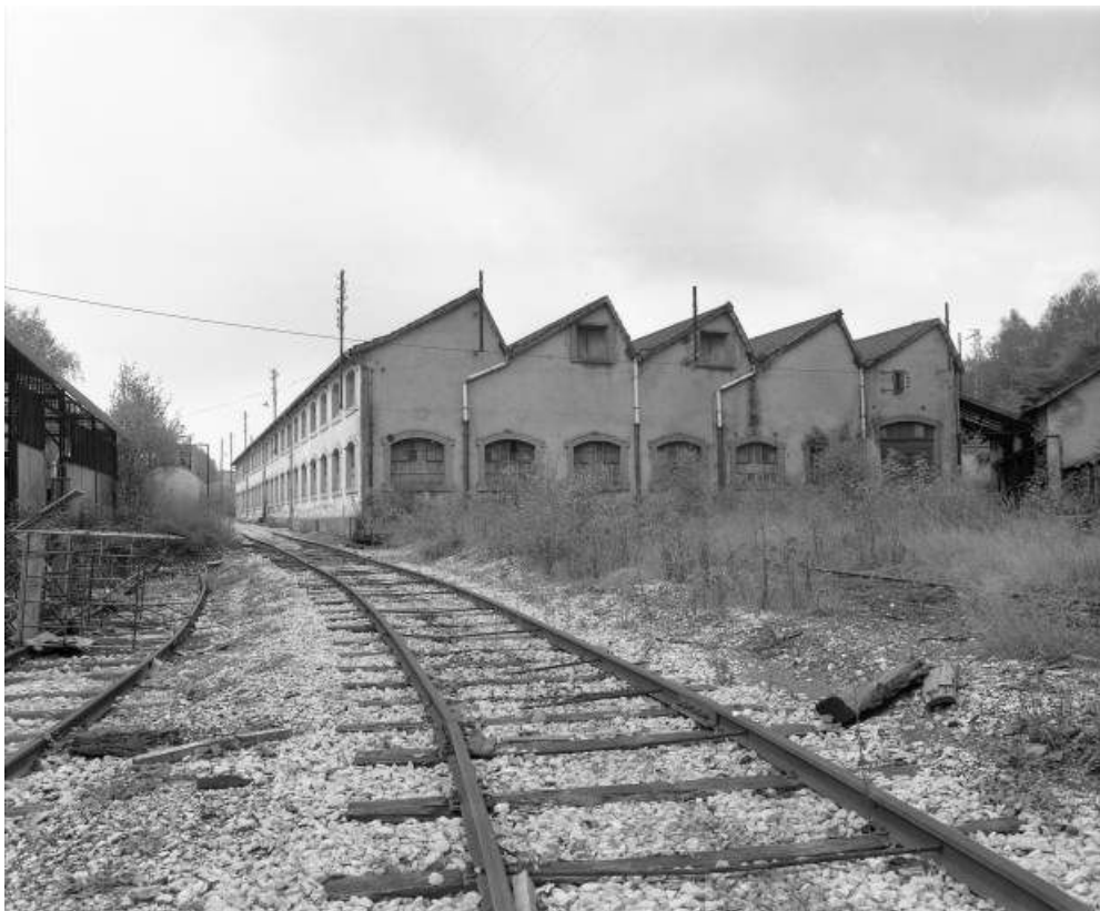
Atelier des pompes depuis l'ouest en 1981.
