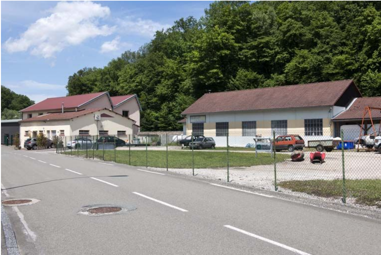
Vue rapprochée depuis le nord-ouest.
