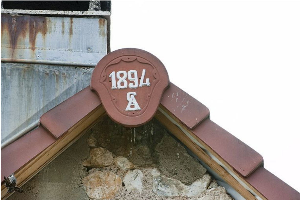
Antefixe d'une maison (rue de la Gaïeté).
