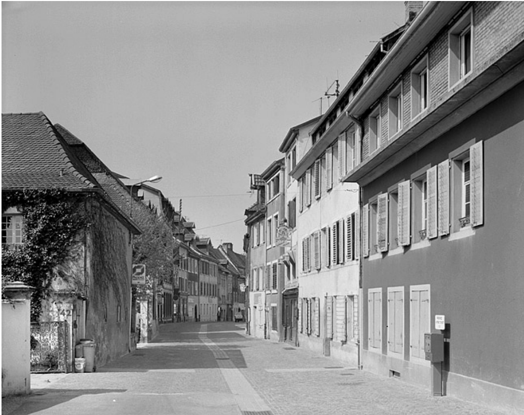
Rue de Belfort. 25, Montbéliard
