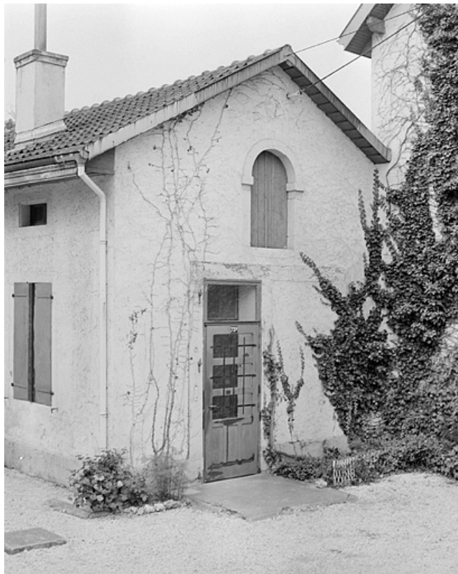
Anciennes écuries. Façade nord.
