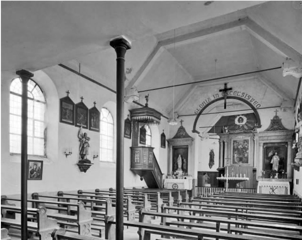
La nef depuis l'entrée.
