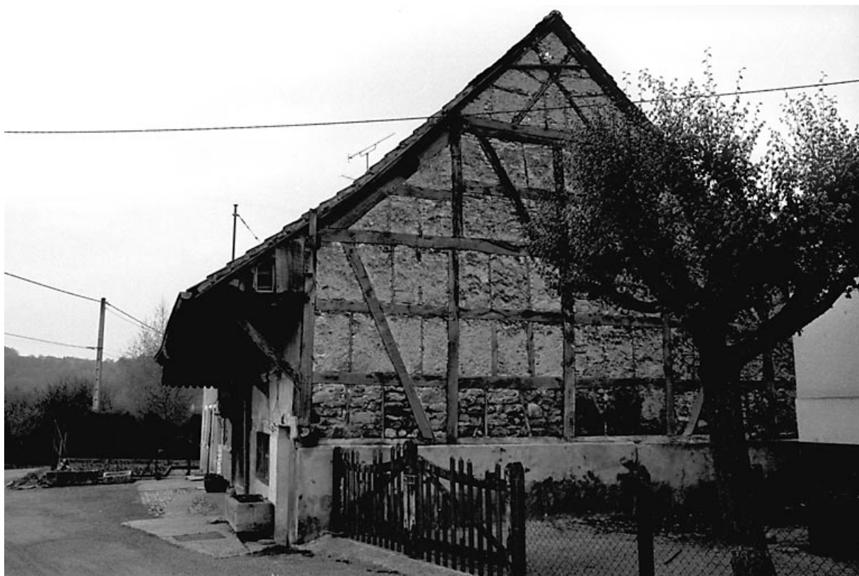
Vue du pignon droit.
