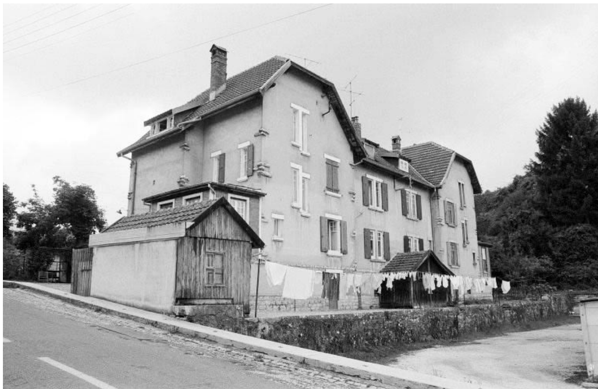
Vue d'ensemble : façade postérieure.
