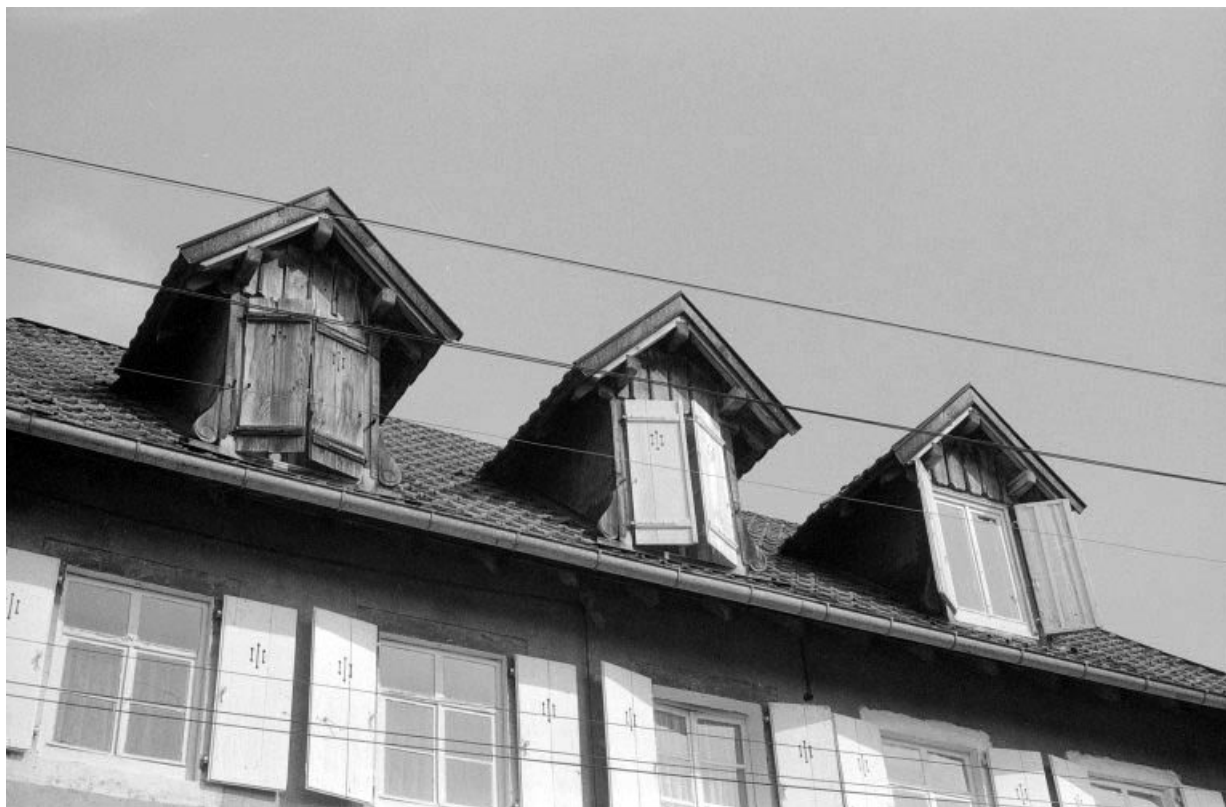
Façades antérieure : détail des lucarnes.
