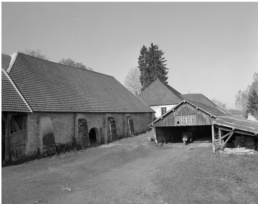
Vue de la halle à charbon.
