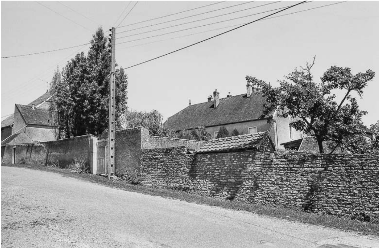
Maison cadastrée 1980 C1 1335 : vue d'ensemble. 70, Valay
