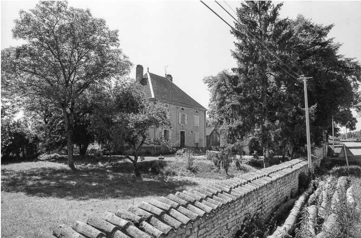
Vue d'ensemble depuis la rue.
