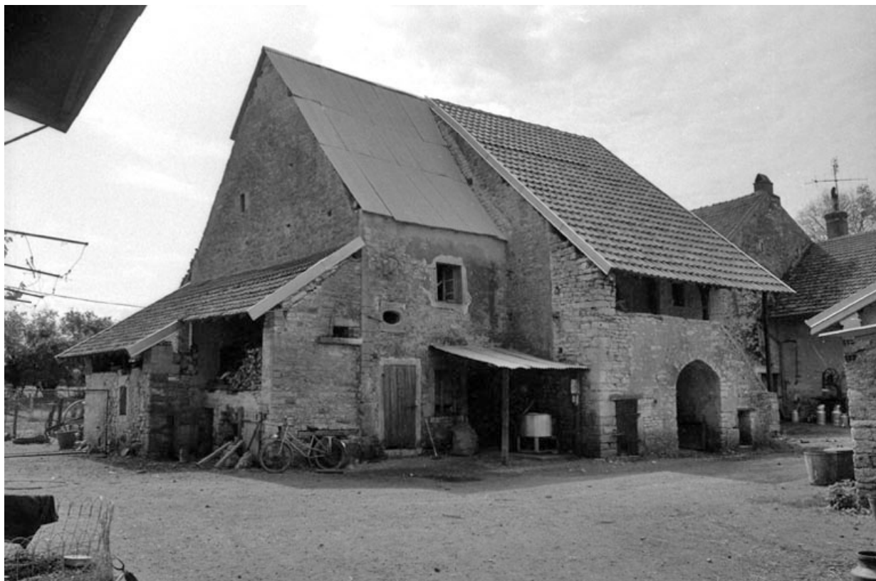
Façades antérieure et latérale gauche.
