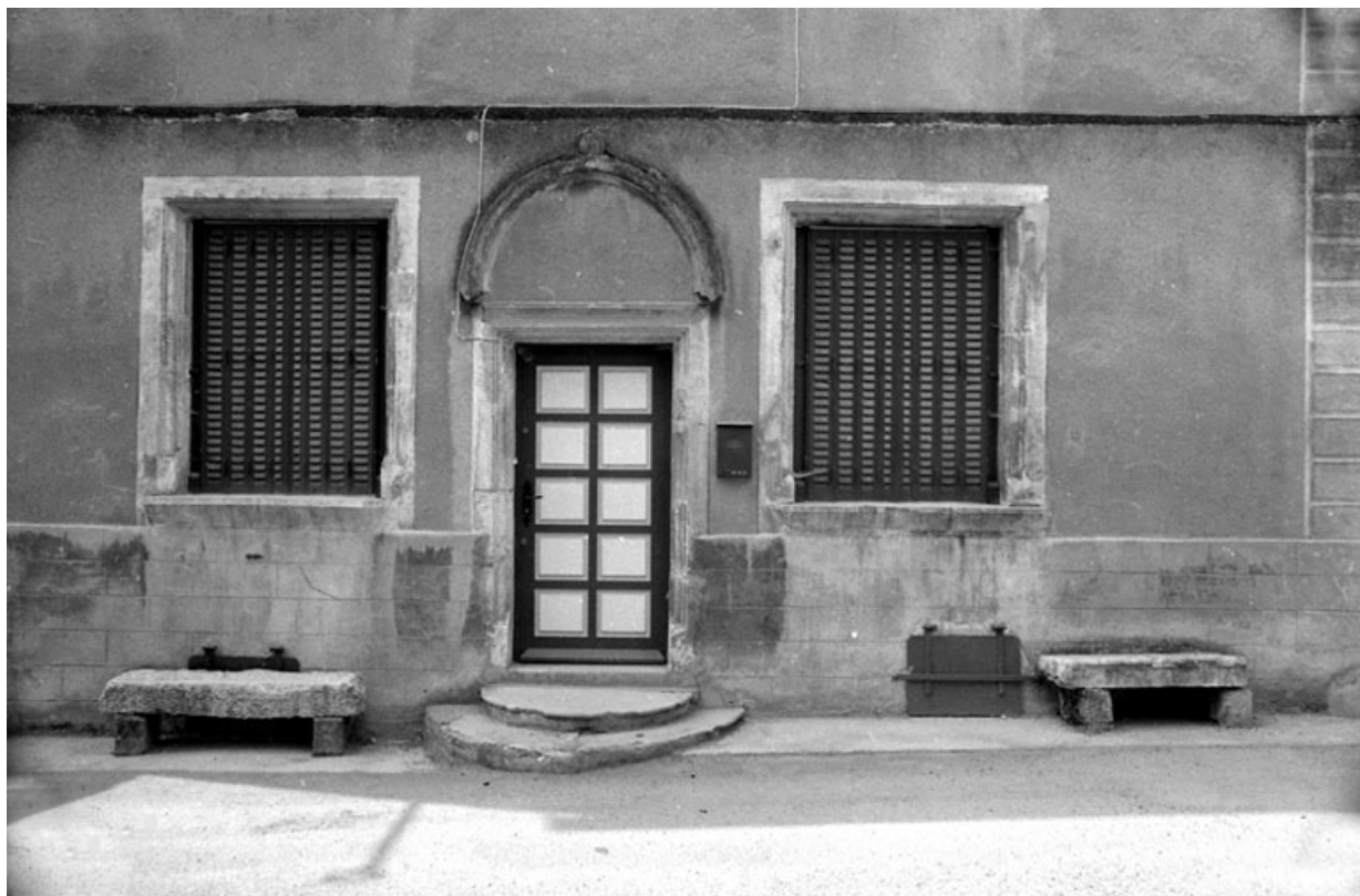
Détail : le rez-de-chaussée.
