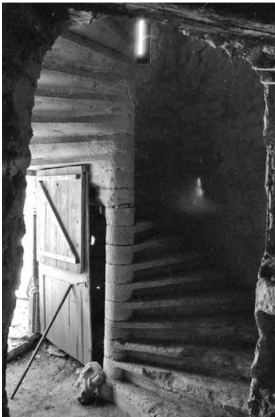
Détail : escalier en vis.
