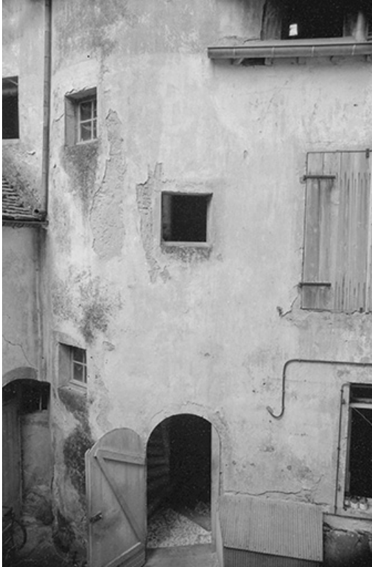
Bas de la tourelle d'escalier.
