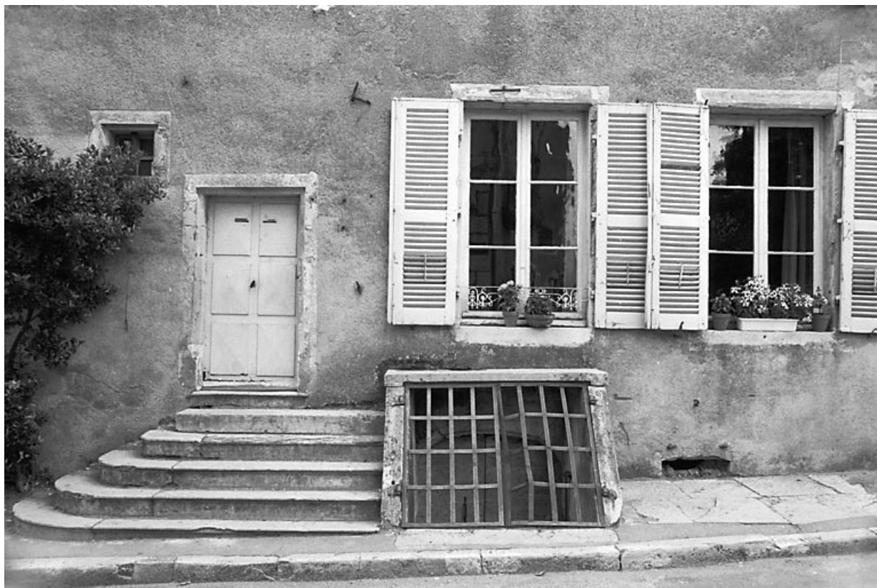
Détail du rez-de-chaussée.
