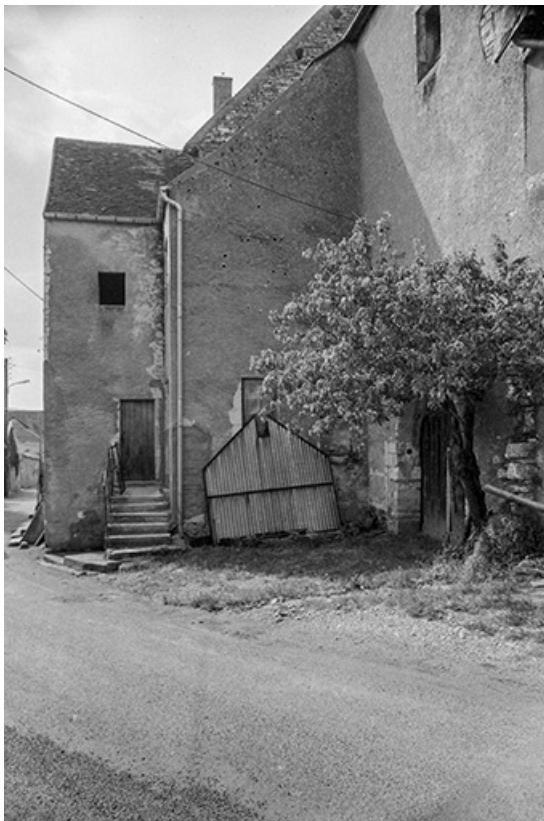
Façade rue des Châteaux, trois quarts gauche.
