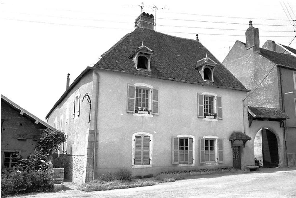
Vue d'ensemble de l'habitation depuis la rue.
