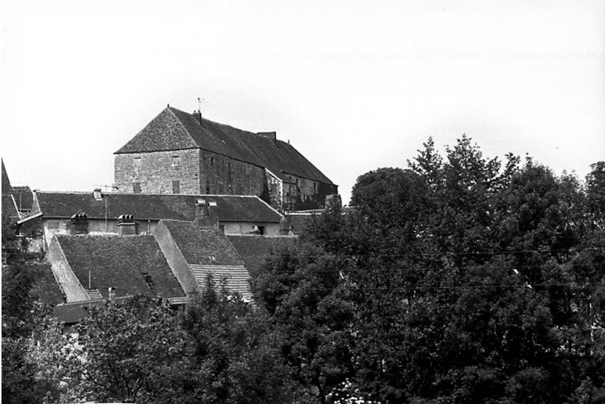
Vue d'ensemble éloignée.
