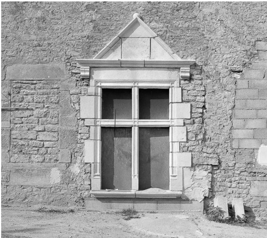
Détail d'une fenêtre restaurée de l'habitation.
