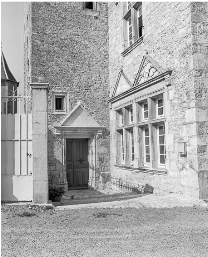
Entrée de l'escalier en vis.
