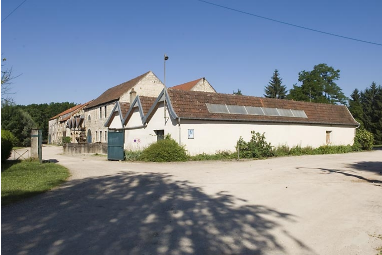
Vue d'ensemble depuis l'entrée.
