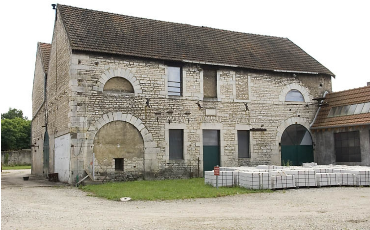
Bâtiment du haut fourneau est.
