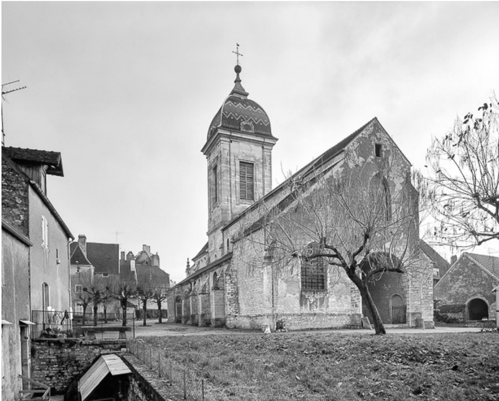
Extérieur : façade ouest.
