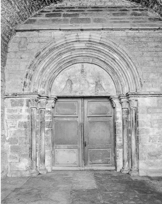
Exérieur : portail ouest.
