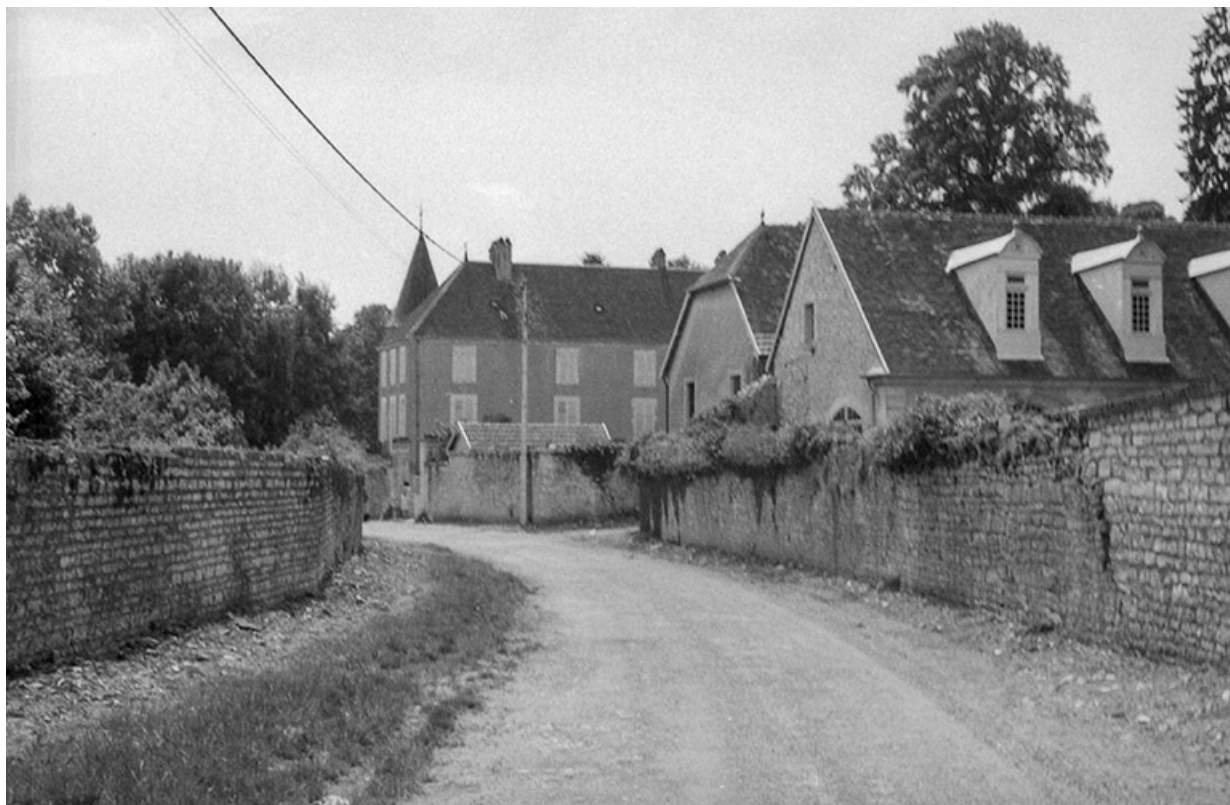
Vue d'ensemble depuis la rue.
