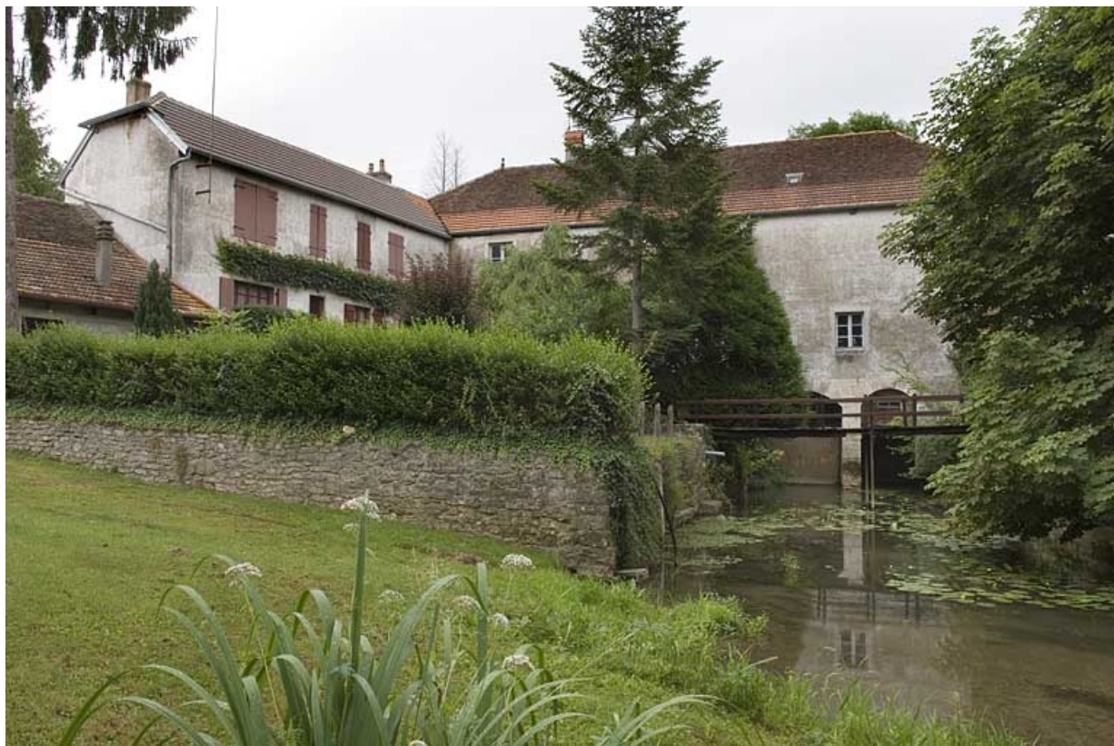
Vue d'ensemble depuis le bief, en aval.
