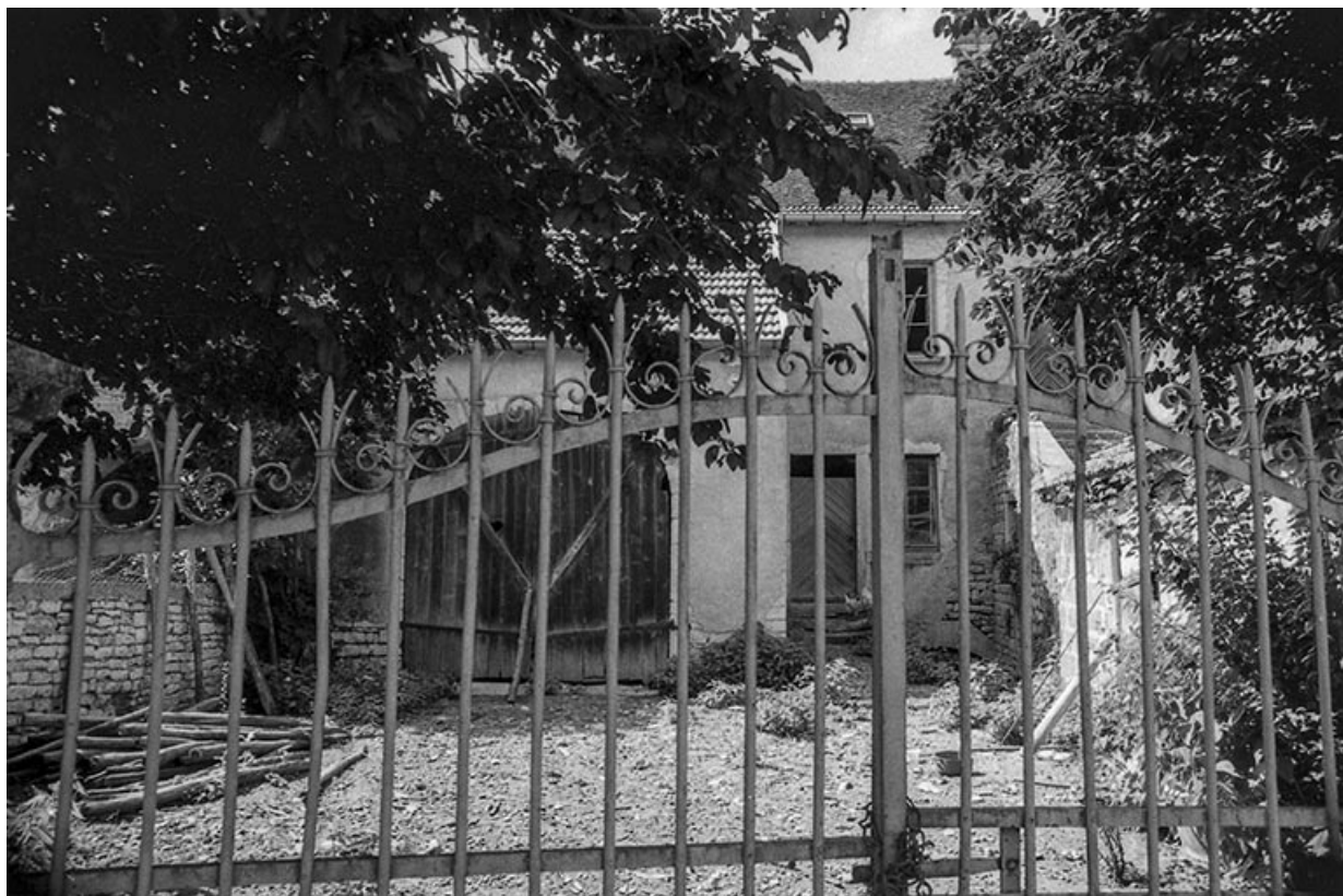
Façade antérieure vue depuis la grille d'entrée.
