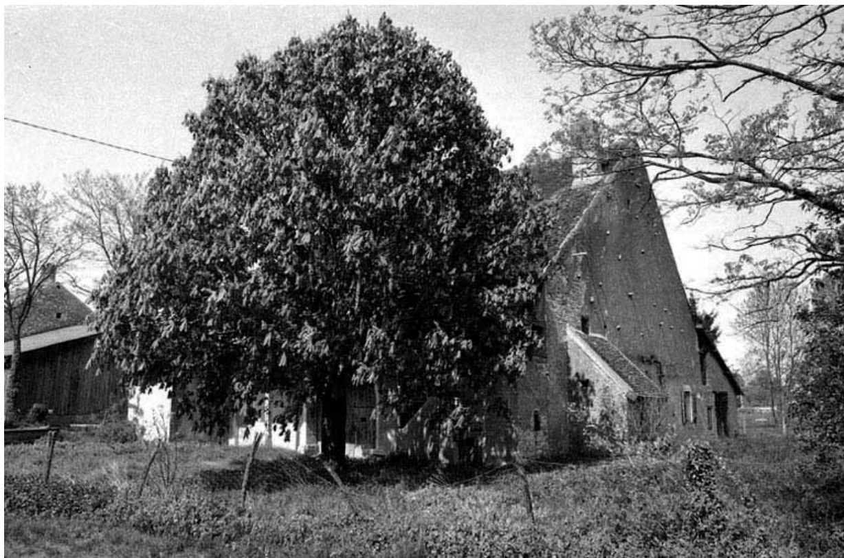
Façade latérale droite.
