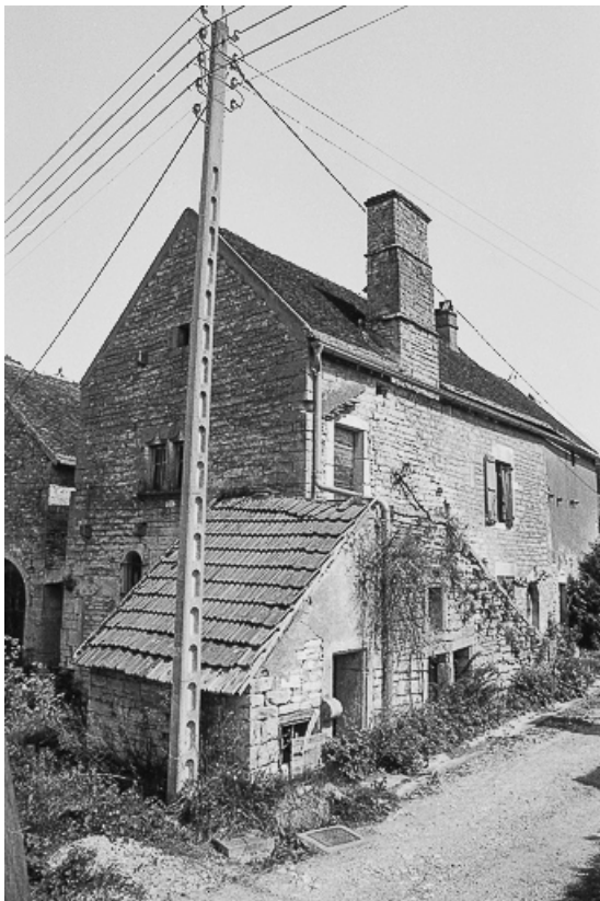
Façade antérieure et latérale gauche.
