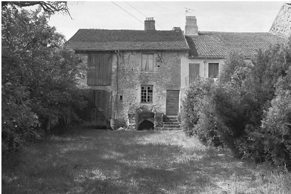
Façade antérieure sur cour.
