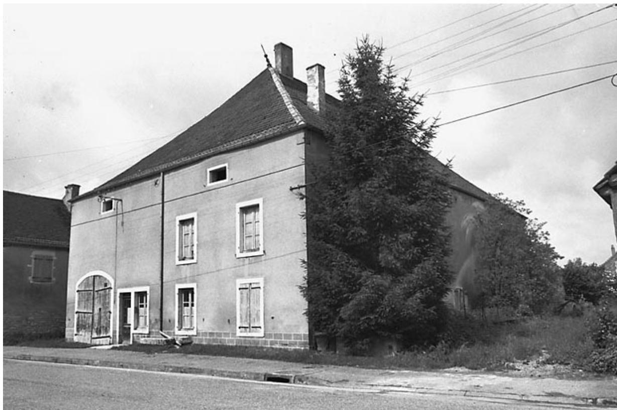
Façade antérieure sur rue.
