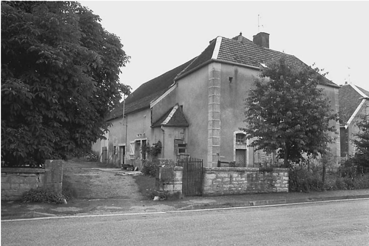
Vue du bâtiment de trois quarts gauche.
