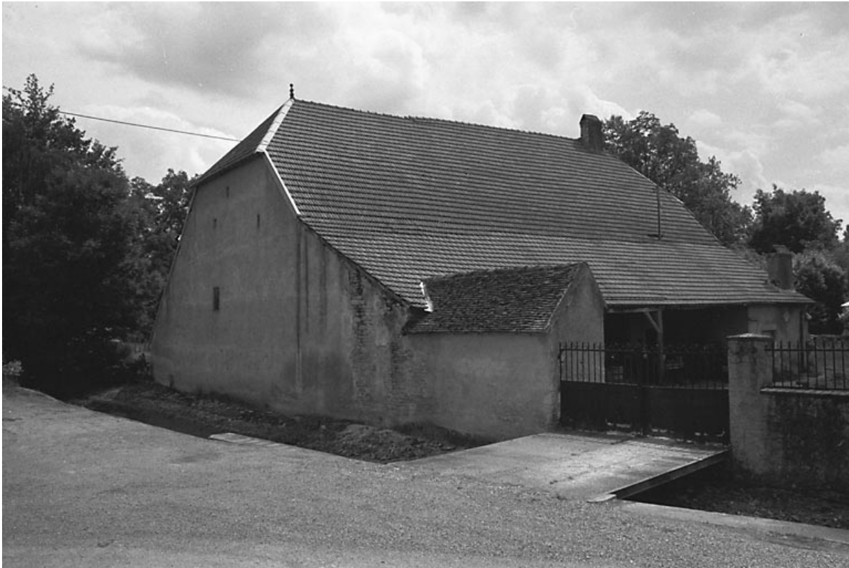
Façades antérieure et latérale gauche.
