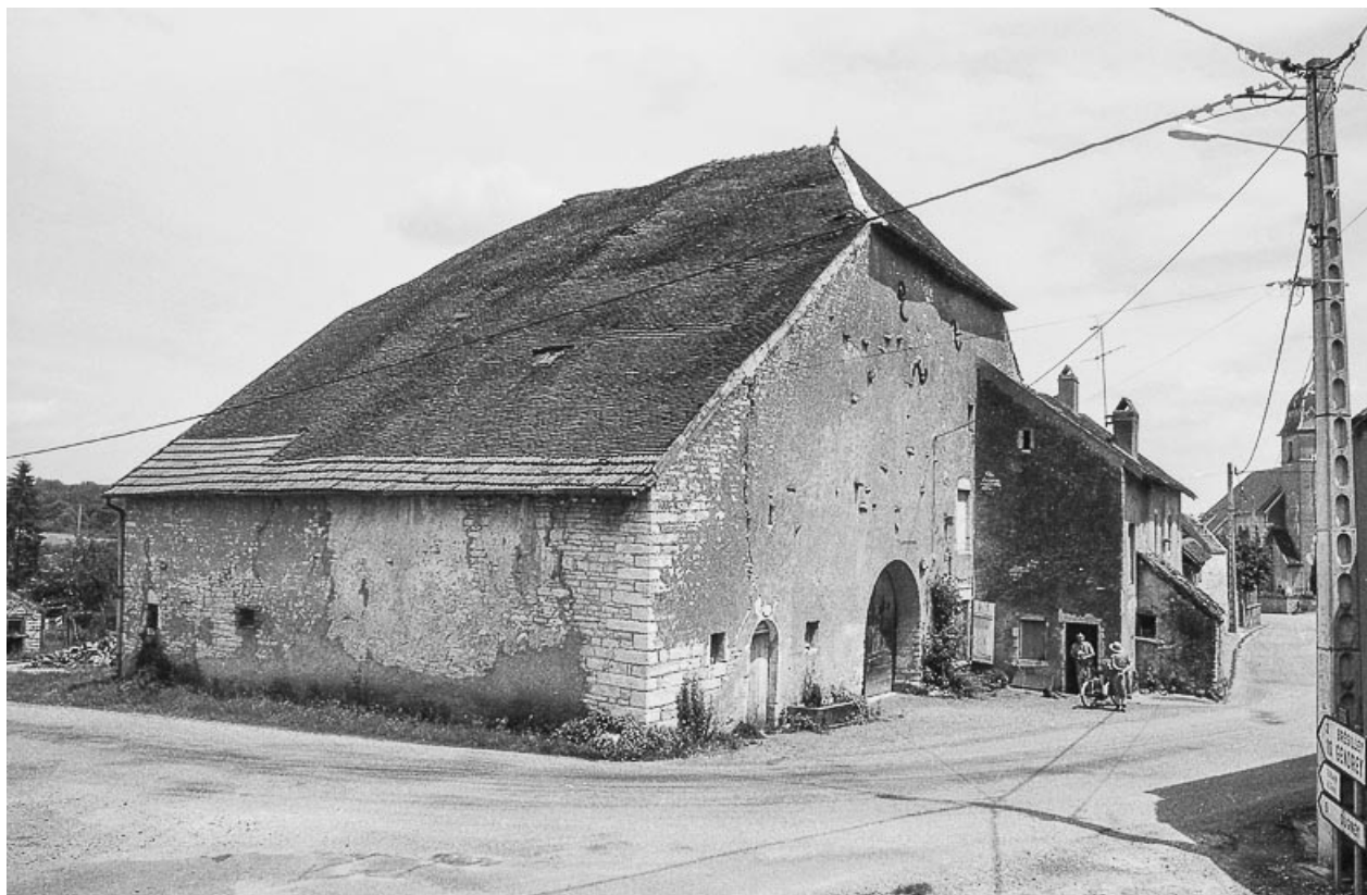
Façades antérieure et latérale gauche.
