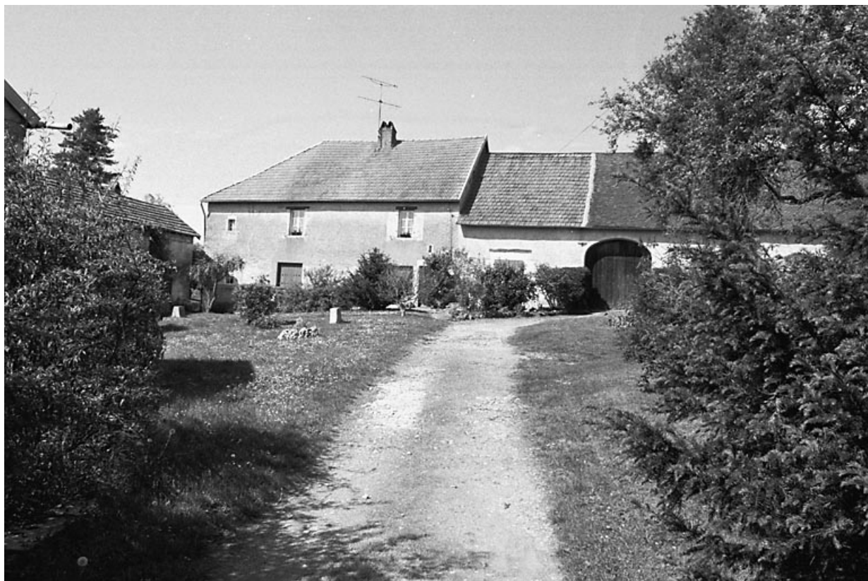
Vue d'ensemble depuis l'entrée de la cour.
